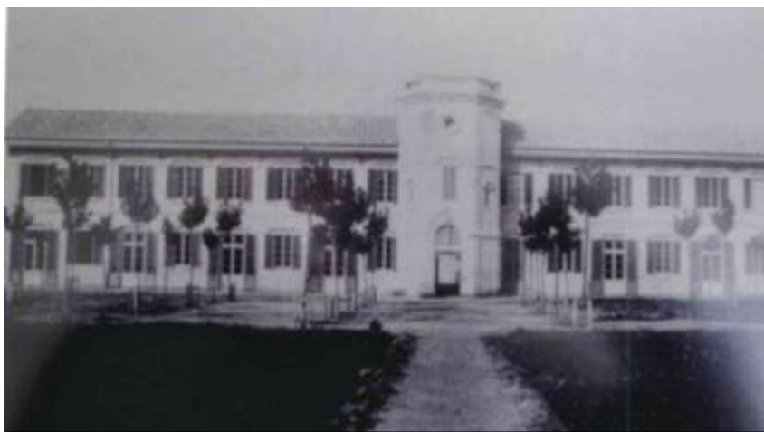
Vista principal de la façana de la Casa de Formació d'Els Hostalets de Llers
