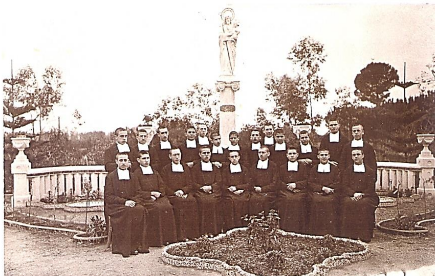
1934. Inauguració del Monument a Sant Josep. La tanda d'agost de 1933 i la tanda de presa d'Hàbit del 18 de març de 1934. Malgrat d'haver sofert la persecució de 1936, la perseverança ha estat del 50%
